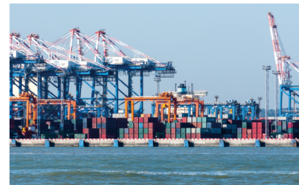
04 港口码头 Port Terminal
