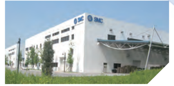
■ 北京第四工厂/The fourth factory 占地面积 / Total land area: 92,874m 2 建筑面积 / Total floor area: 71,843m 2
