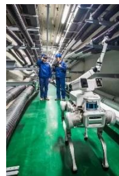
亚运村 地下管廊隧道 运维巡检
