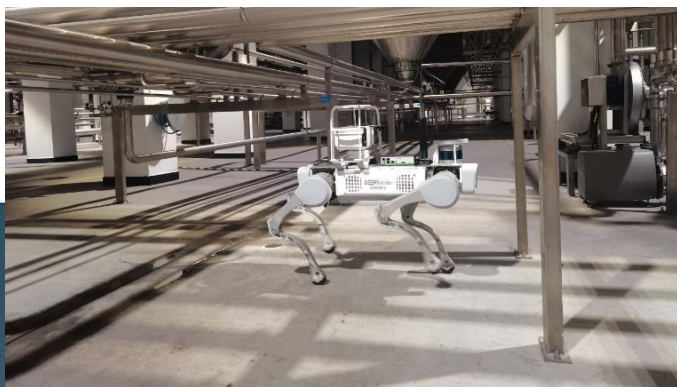
上海 某知名品牌啤酒厂自主巡检
